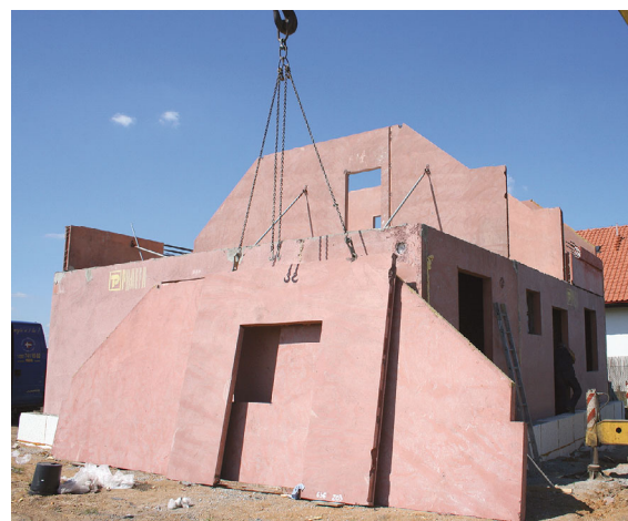
Fot. 1. Montaż prefabrykatów keramzytobetonowych (fot. Lipiński Domy)
