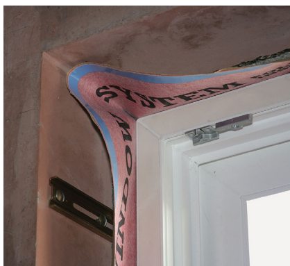
Fot. 3. Szczelne połączenie ścian zewnętrznych ze stolarką okienną – folia paroszczelna przed przyklejeniem (fot. Lipińscy Domy)
