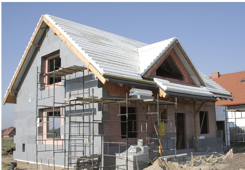
Fot. 2. Izolacja ścian zewnętrznych wykonana z 30 cm szarego styropianu oraz styropianowe panele dachowe (fot. Lipińscy Domy)
